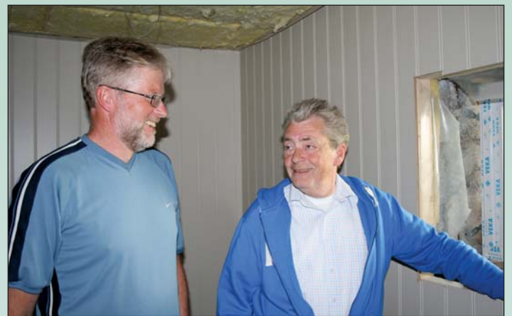
Emil Balstad og Oddleif Bøe er godt nøgde med oppussingsarbeidet så langt.
